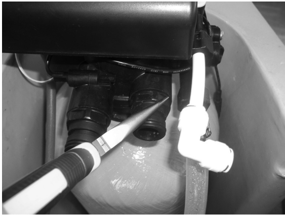
Fig. H - Adaptador largo instalado
